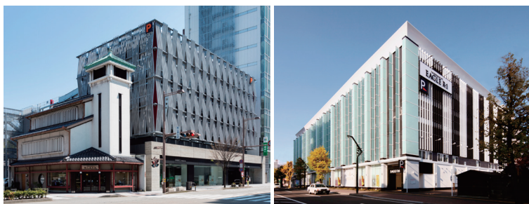
施設併用型駐車場の建設事例
