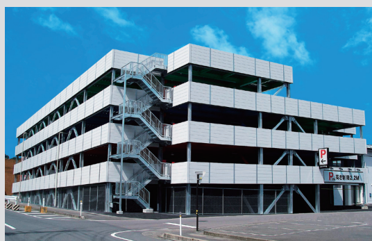
認定自走式駐車場。外壁を持たない開放的な構造が特徴
